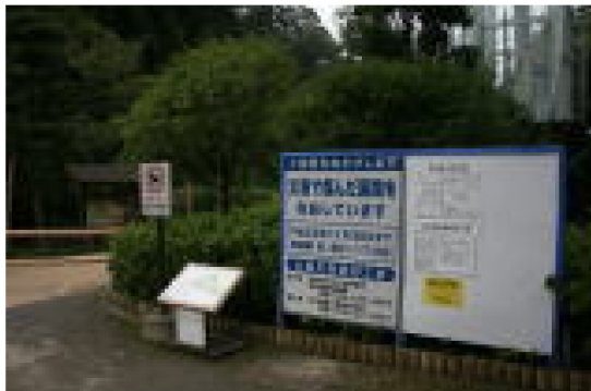
復旧工事の案内
