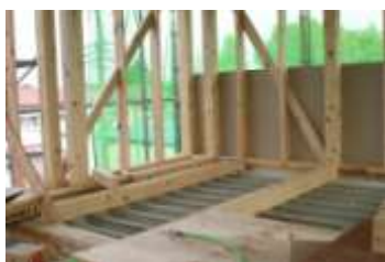
図 4(2)3F 増築、外壁追加作業
