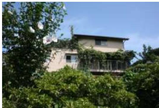
図 1 自宅 南側 左上が屋上
