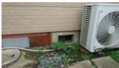
図 7 風呂場近くの通路遮断
